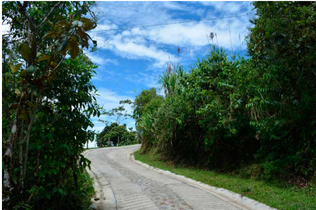
Figuras 4.1 y 4.2. Chiva varada en parte destapada y tramo de placa-huella de la carretera de Palmirita
