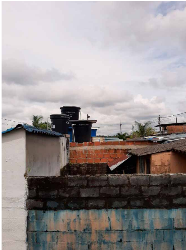
Figura 2. Tanques de almacenamiento
