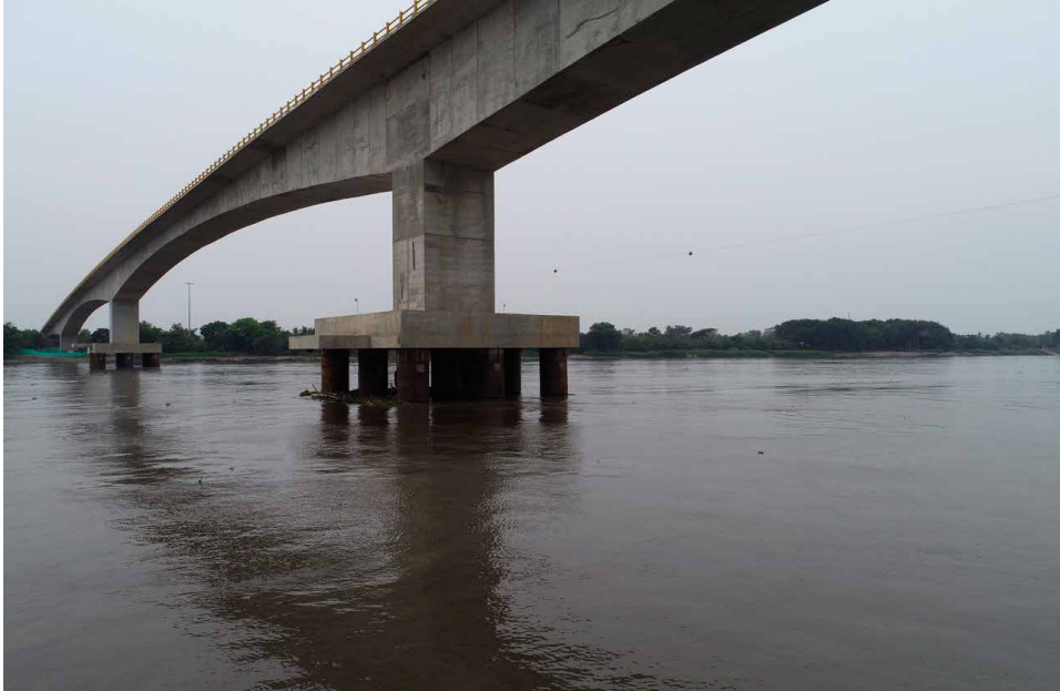
Figura 1. Puente Roncador. Abril de 2019
