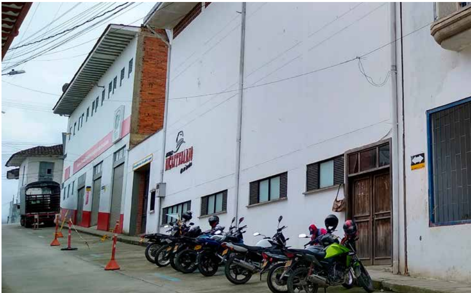
Figura 4. Fachada frontal del Teatro Bicentenario
