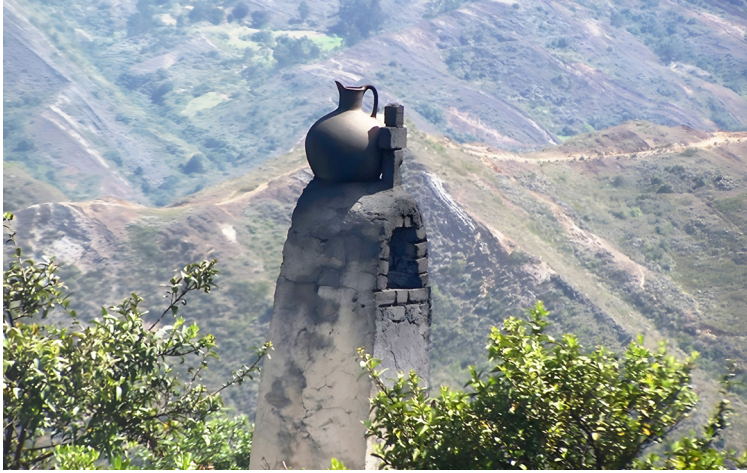
Figura 2. Copa de la chimenea del horno
