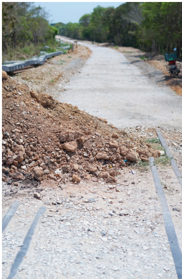
Figura 9. Tramo de vía en proceso de rehabilitación. Comunidad de Mogoñé Viejo, Guichicovi, abril de 2023
