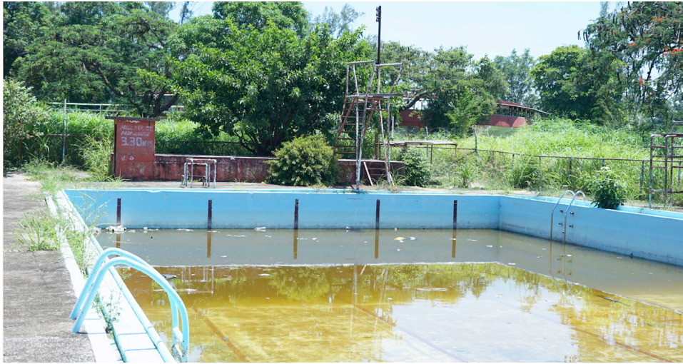
Figura 3. Interior del Deportivo Ferrocarrilero Víctor Flores, en Matías Romero, Oaxaca, agosto de 2023
